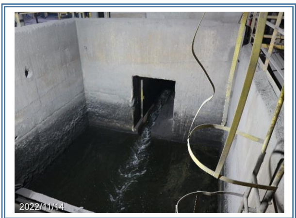
รูปที่ 3.8 บ่อตกตะกอน (Scale) ภายในโรงเหล็กแห่ง
