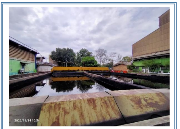
รูปที่ 3.6 บ่อดักคราบน้ำมันและจาระบีภายในโครงการ
